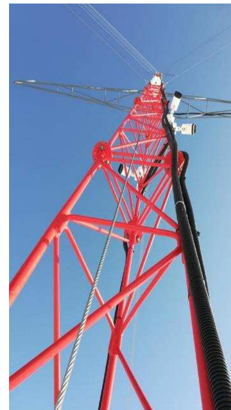
Maszt pomiarowy w Lubiatowie
